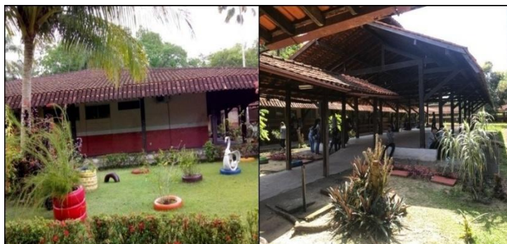
Figura 9 - CEFI – Bloco de Sala de Aula - Estrutura da Cobertura das Passarelas e do Pátio
