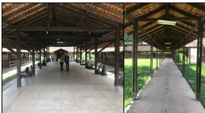
Figura 10 - CEFI – Pátio Coberto, Corredores de Acesso aos Blocos
