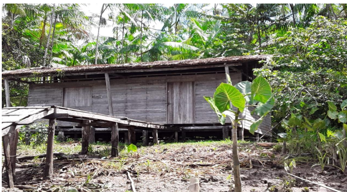
Figura 4 - EMEF Ideal localizada no Distrito Curumú, no meio rural.
