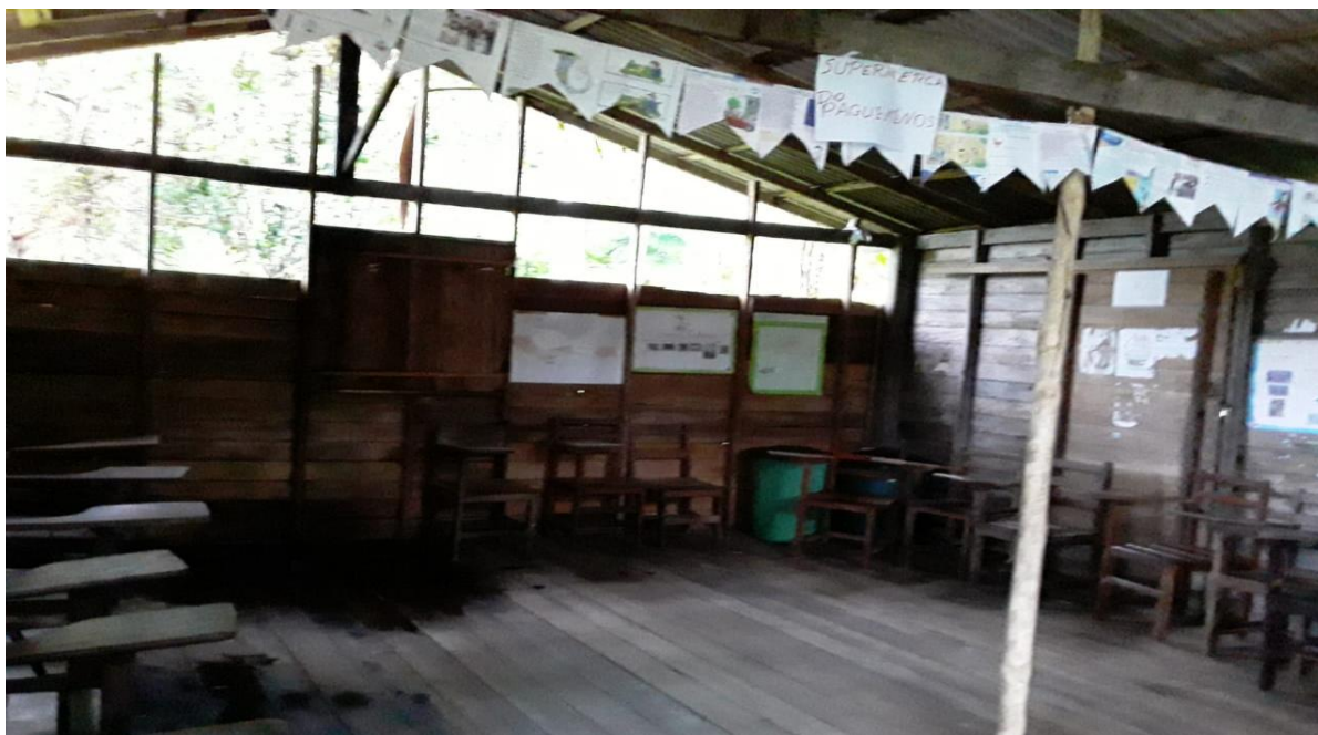
Figura 5 - Estrutura física da EMEF Ideal.
