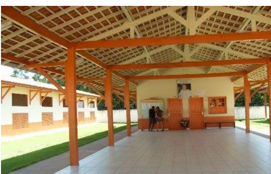
Pátio e bloco administrativo
