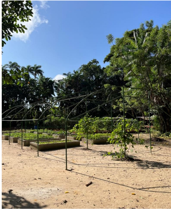
Figura 14- Estrutura da estufa sem cobertura
