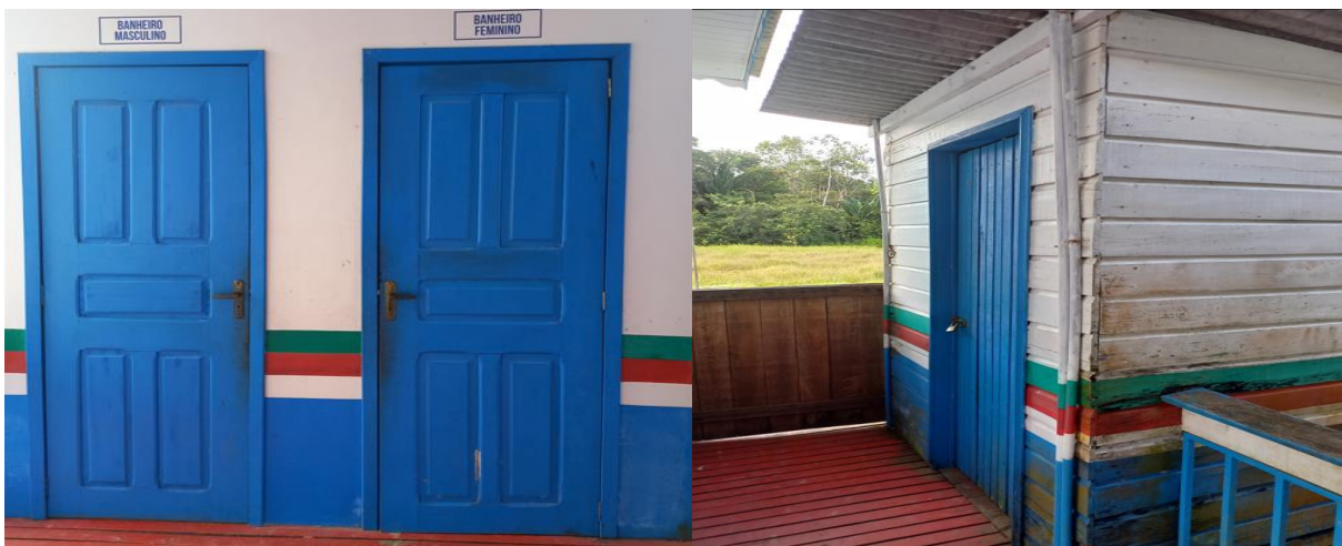
Figura 14 – Banheiro masculino/feminino e depósito de limpeza.
