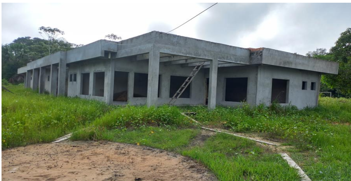
Figura 17 – Creche Proinfância Tipo 2 da Escola São Tomé em construção.
