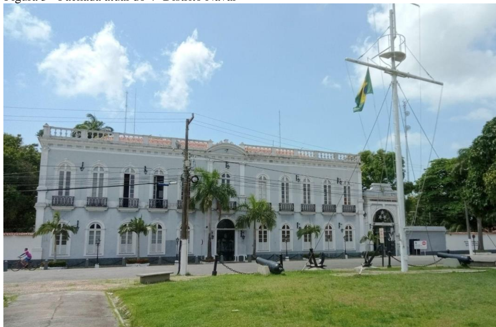
Figura 3 - Fachada atual do 4º Distrito Naval
